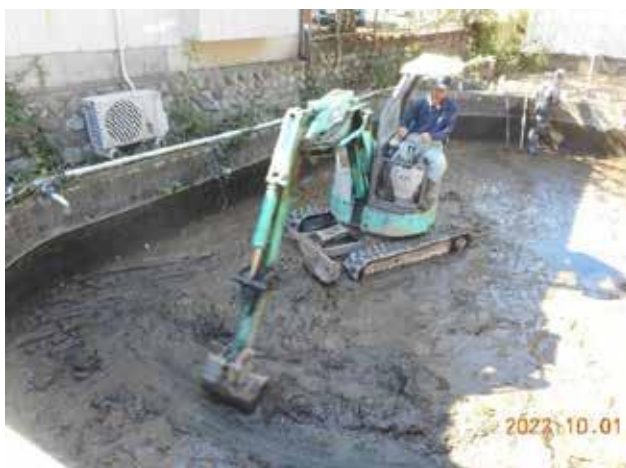
水槽の中の汚泥撤去も大変な作業となりました
