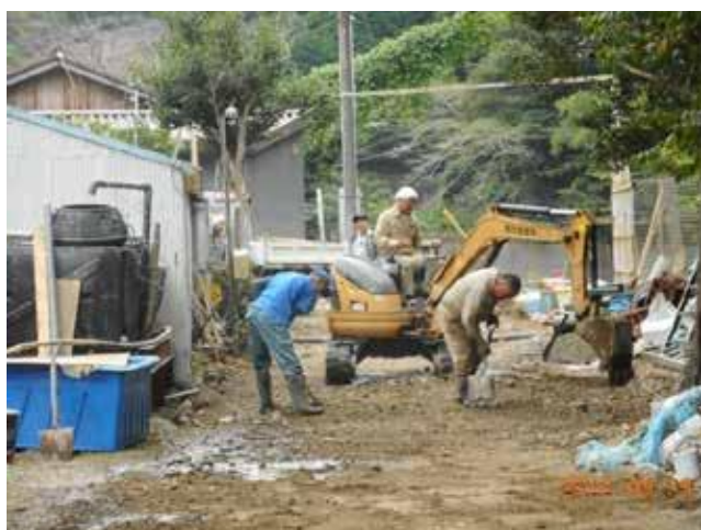
施設周りに堆積した泥除けと通路の片付け作業
