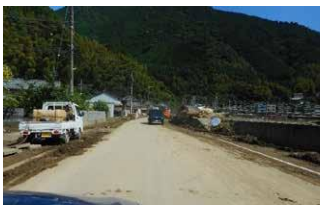
高瀬付近道路は、堤防を越した泥水に埋まった
