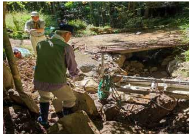
会員の人力による土石の撤去でようやく元の姿に
