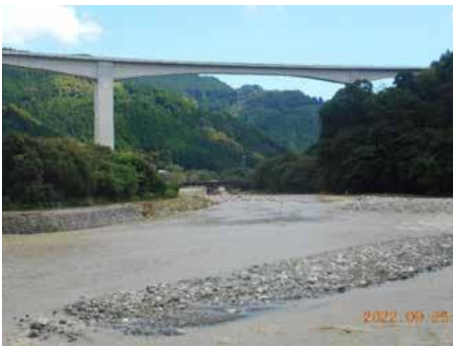
河川のいたるところに見られる土砂堆積状況
