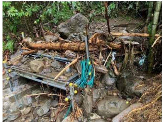
大量の土砂、流木により埋もれてしまった水道施設
