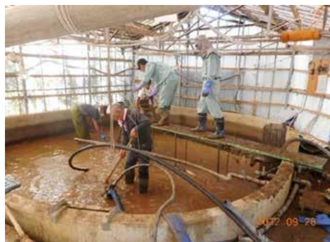
屋内水槽の汚泥撤去に追われる日々が続きました
