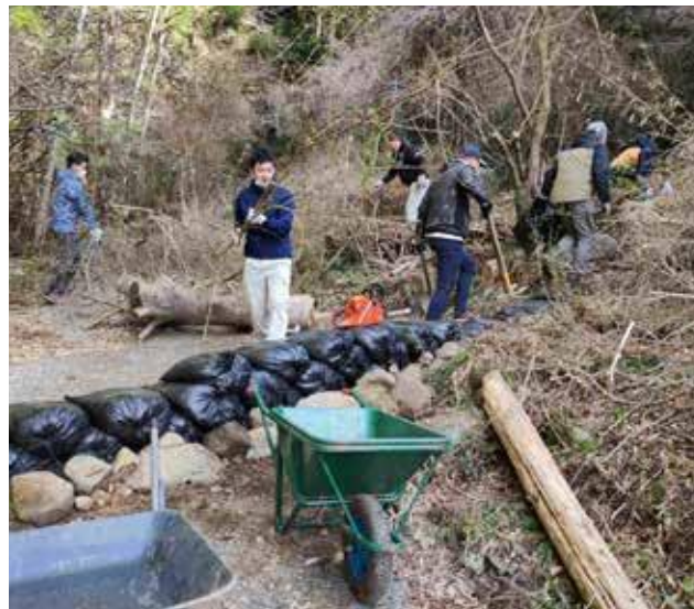
土嚢を積み、山側からの水を沢の方へ誘導した
