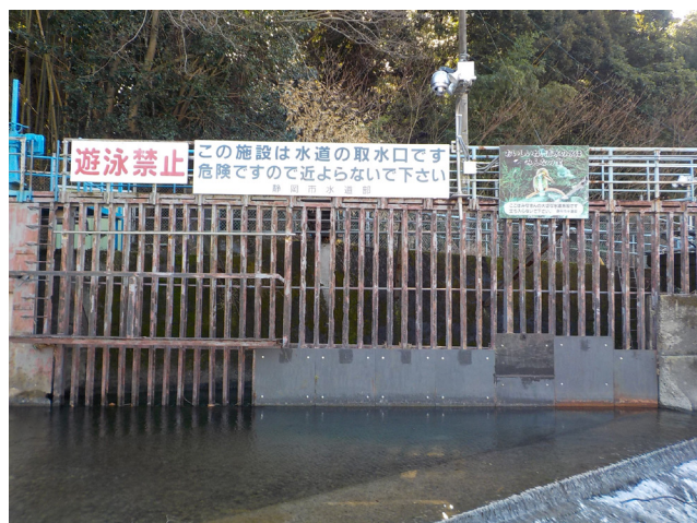
承元寺の水道水取水口
