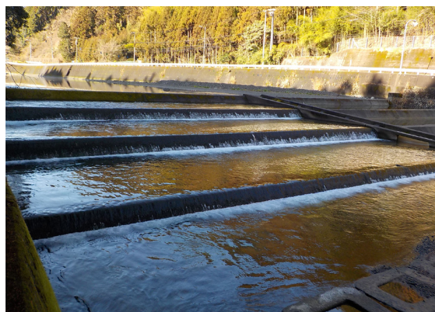
階段状の堰の流れが美しい和田島カスケード魚道工
