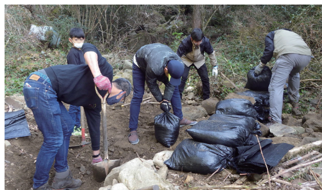
山からの水を沢の方へ誘導する土嚢積み作業
