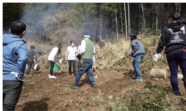
土砂に埋もれた広場の復旧作業を協力して行う
